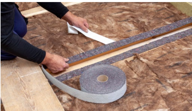
Bild 7: GIFAfloor Auflagerdämmstreifen auf Tragkonstruktion kleben.
