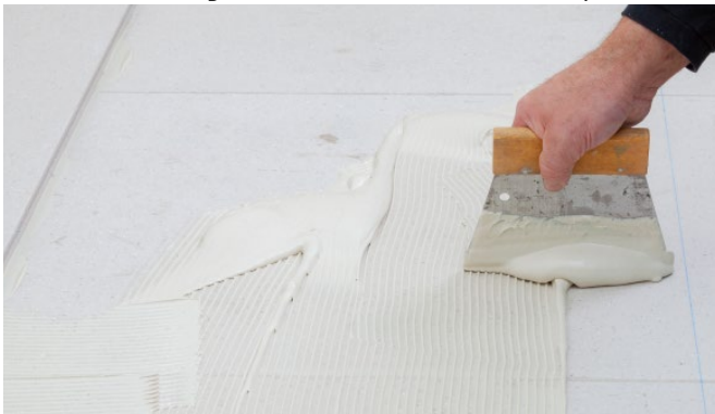
Bild 16: Verteilung GIFAbond duo EC 1 mittels Zahnspachtel.
