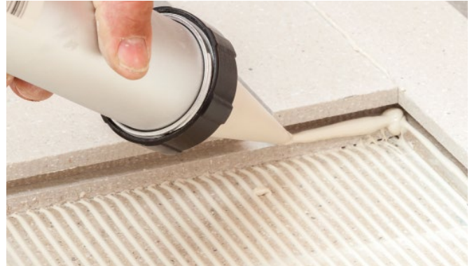
Bild 19: Auftrag des Klebstoffes an der Oberseite der Feder.
