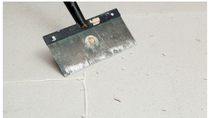
Bild 14: Ausgetretenen Klebstoff am Folgetag abstoßen.
