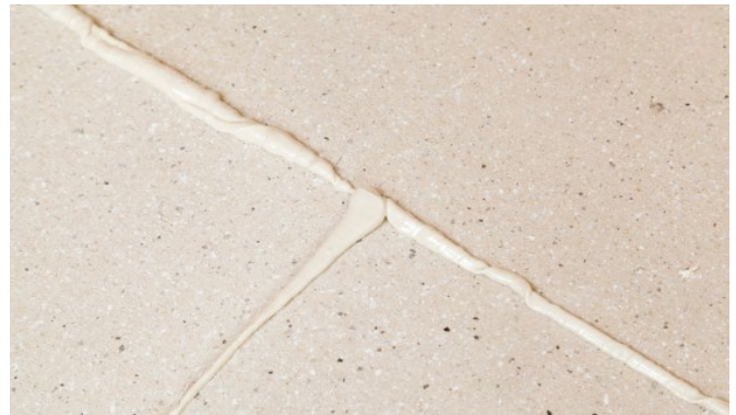
Bild 20: GIFAfloor PRESTO Elemente press fügen.
