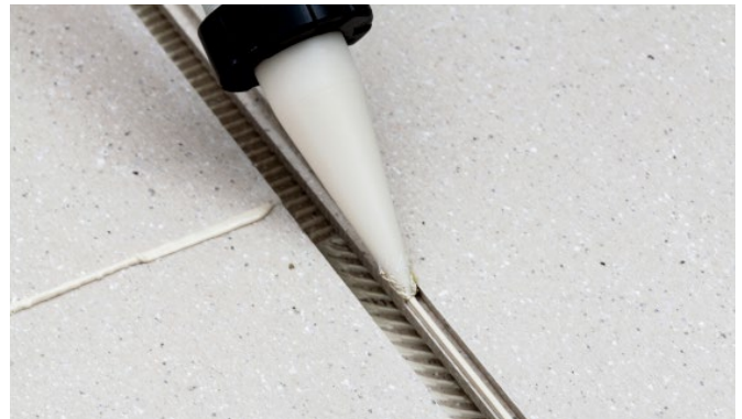
Bild 20: GIFAfloor PRESTO Elemente press fügen.
