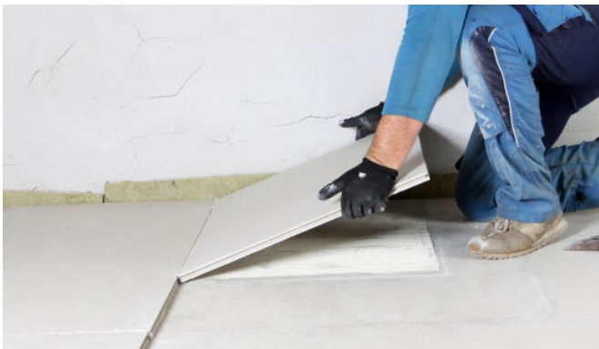
Bild 17: GIFAfloor PRESTO Bodenelemente in Klebebett einlegen.
