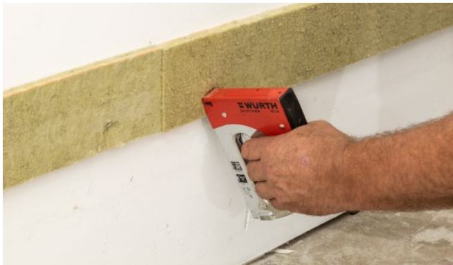
Bild 6: GIFAfloor Randdämmstreifen mit Tackernadeln oder Knauf Uniflott befestigen.
