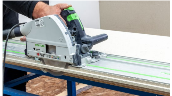
Bild 9: Zugeschnittenes GIFAfloor PRESTO Bodenelement im Wandanschlussbereich montieren.
