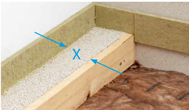
Bild 3: Auflagerabstand an der Wand.
