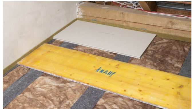
Bild 9: Zugeschnittenes GIFAfloor PRESTO Bodenelement im Wandanschlussbereich montieren.
