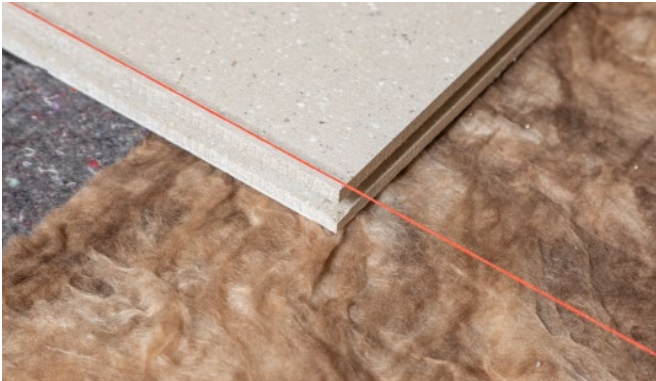
Bild 11: Zuschnitt des Wandanschlusselementes mit Handkreissäge und Sägeblatt GIFAtool Diamond.
