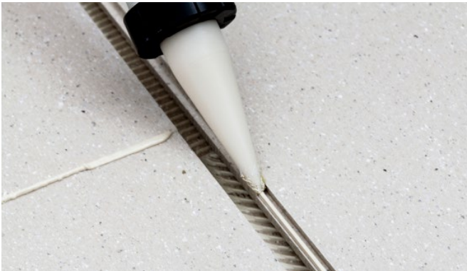
Bild 12: Verklebung der Nut/Feder-Verbindung.
