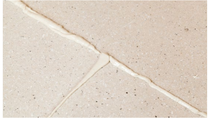
Bild 13: GIFAfloor PRESTO Elemente press fügen.
