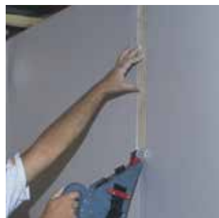
Hjørnespartling. Maskinen holdes i 45°
