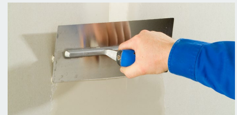
6. Fuge mit Fugendeckstreifen planeben überspachteln.
