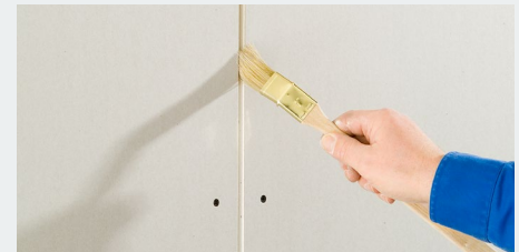
3. Fuge staubfrei machen. Vor dem Füllen den offenen Gipskern zur Staubbinding und Saugfähigkeitsregulierung grundieren (z.B. mit Knauf Tiefengrund).
