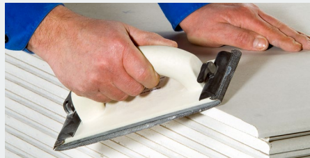
2. Brechen mit dem Handschleifer bei Knauf Cleaneo-Platten.
