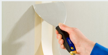
5. Einlegen des Fugendeckstreifens. Mit der Spachtel oder Traufel plan eindrücken sowie überschüssiges Material abziehen.
