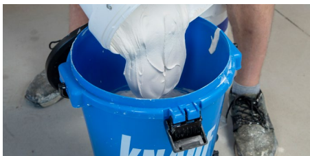
1. Fill & Finish Light anrühren und einfüllen
