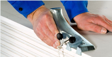
1. Anfasen einer SK mit dem Kantenhobel.
