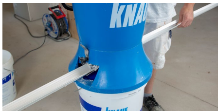
2. Eckschutzschiene Dallas durch den Hopper ziehen
