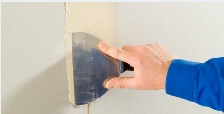
4. Eindrücken der Spachtelmasse. Danach so abziehen, dass ein gleichmäßiger, ca. 10 cm breiter und mindestens 1 mm dicker Spachtelmassen-Film entsteht.
