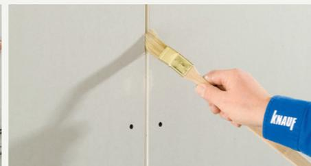
3. Fuge staubfrei machen. Vor dem Füllen den offenen Gipskern zur Staubbindung und Saugfähigkeitsregulierung grundieren (z. B. mit Knauf Tiefengrund).
