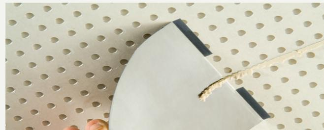
Stoßen Sie überstehenden Knauf Uniflott nach dem Aussteifen mit der Cleaneo-Spachtel ab
