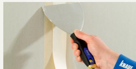
5. Einlegen des Fugendeckstreifens. Mit der Spachtel oder Traufel plan eindrücken sowie überschüssiges Material abziehen.
