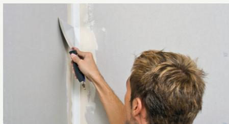
**4.** Mit Spachtel oder Traufel plan rechts und links des Falzes in die Spachtelmasse eindrücken.
