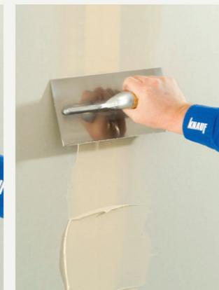
2. Lediglich planeben in Längsrichtung stumpf abziehen.
