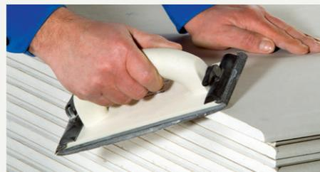
2. Brechen mit dem Handschleifer bei Knauf Cleaneo-Platten.
