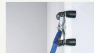
**2.** Die mit Spachtelmasse beschichteten Schienen mit der Papierseite nach oben in bzw. an die Ecke anlegen. Das Profil Dallas mit dem Außeneckroller angedrücken.
