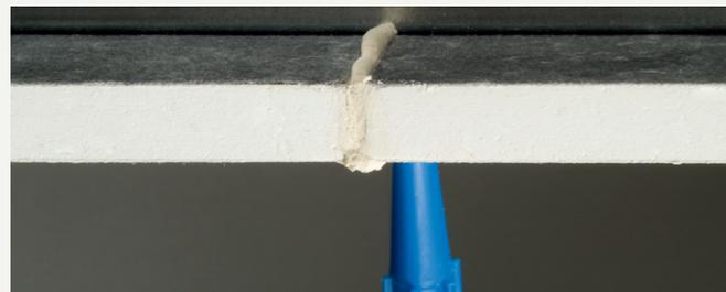
Seitenansicht beim Füllen der Fuge mit Knauf Uniflott
