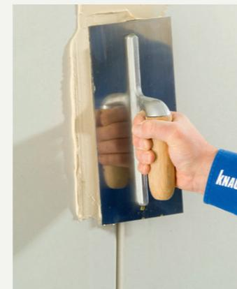
1. Eindrücken der Spachtelmasse quer zur Fuge. Mit Knauf Uniflott ist bei reiner HRAK Fuge kein Fugendeckstreifen nötig.
