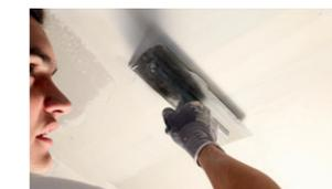
**2.** Mit Knauf Fill & Finish werden sowohl AK-Fugen gespachtelt, als auch Flächen in Q3 und Q4.
