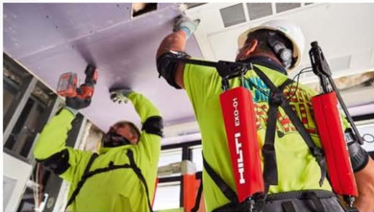
Plafond- en wandmonteurs hebben het passieve exoskelet, de Exo-01 van Hilti, ontdekt.
