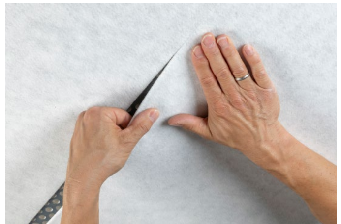
Bild 2: Anbringen des Cleaneo Klett Surface
