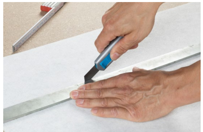
Bild 3: Zuschneiden des Cleaneo Klett Surface
