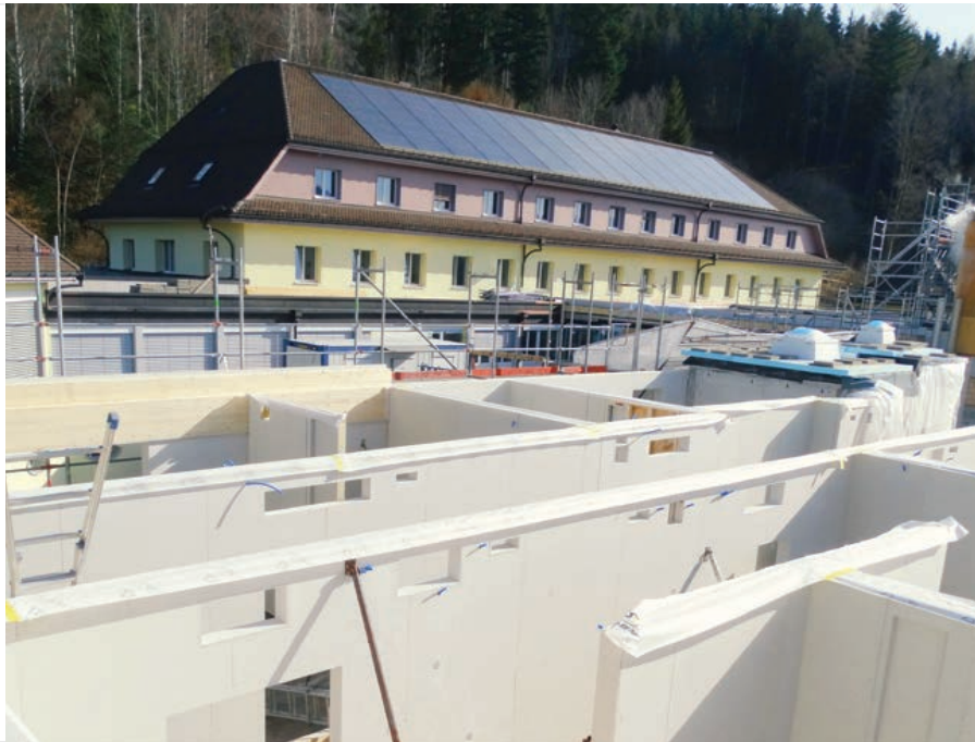
Adelheit kórház (Svájc) - készház technológiával, üzemben gyártott panelekből
