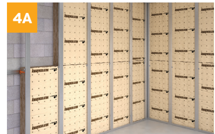
Insertion de l'isolant entre les fourrures
