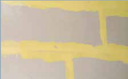
Verspachtelung mit gelbem Safeboard-Spachtelmaterial für höchste Sicherheit
