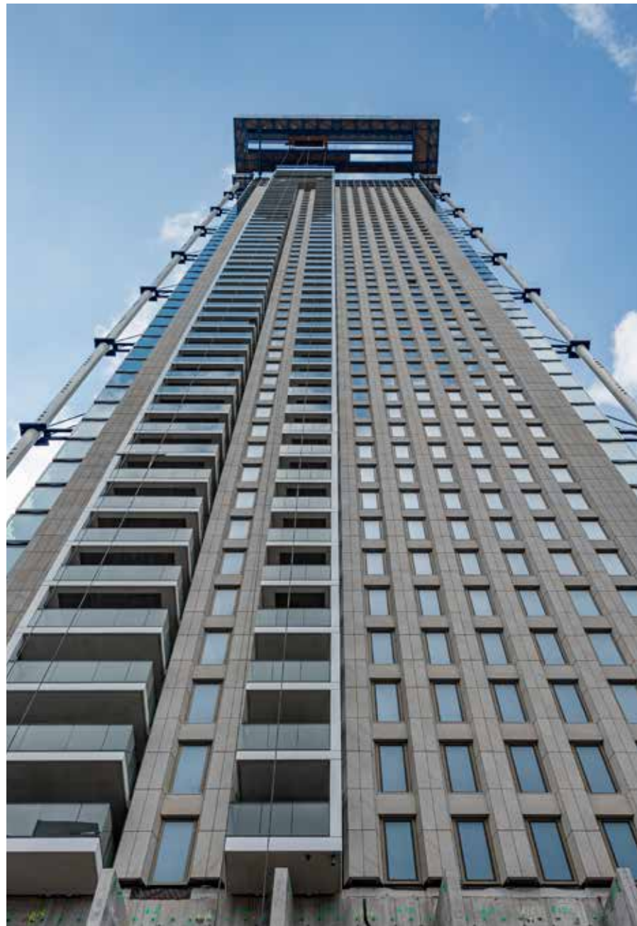
Een mooi voorbeeld van een project waarin Knauw in het complete proces heeft meegedacht, is De Zalmhaven in Rotterdam. In dit project worden alle niet-dragende binnenwanden uitgevoerd met gipsblokken, die conform het KnauwZeker concept zijn geleverd. (Beeld: Jan de Vries)
