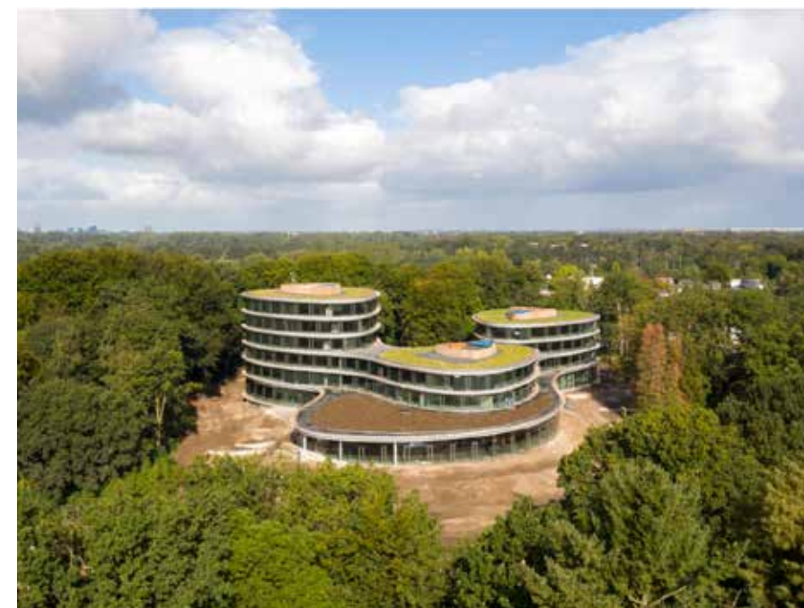
In de duurzame nieuwbouw van de Triodos Bank in Driebergen-Rijsenburg is een heel specifiek systeem voor de binnenwanden toegepast: het Knauw Hybride Circulair wandsysteem.
