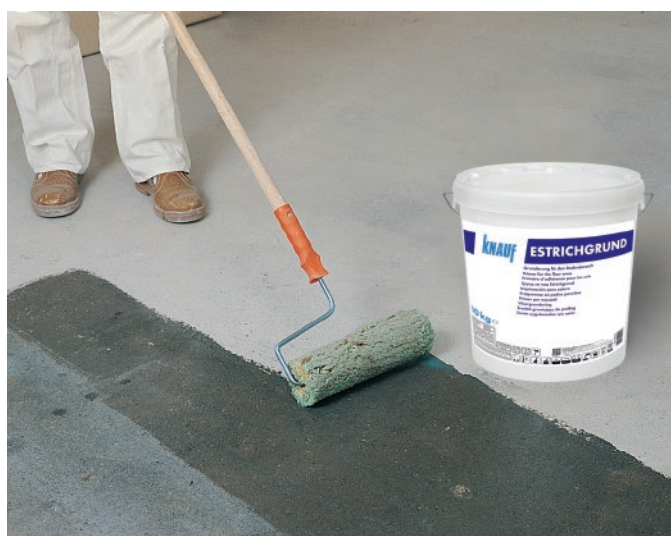
Grafika 55: Nanoszenie środka gruntującego Knauf Estrichgrund
