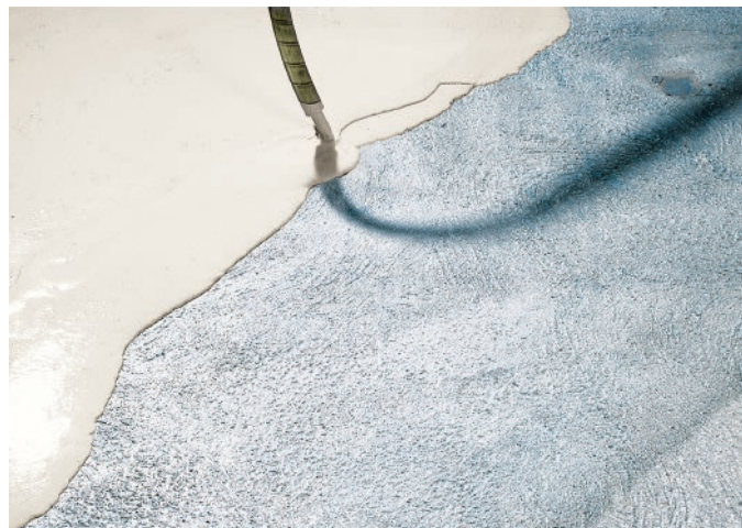
Grafika 57: Maszynowe wykonanie Knauf N 410
