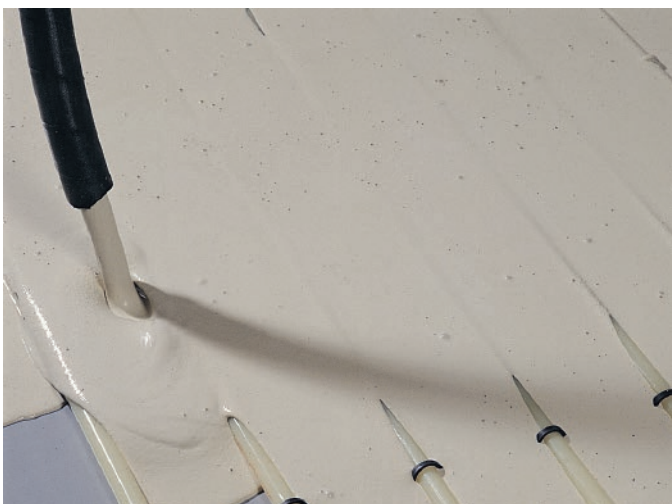
Grafika 10: Aplikacja anhydrytowego podkładu grzewczego
