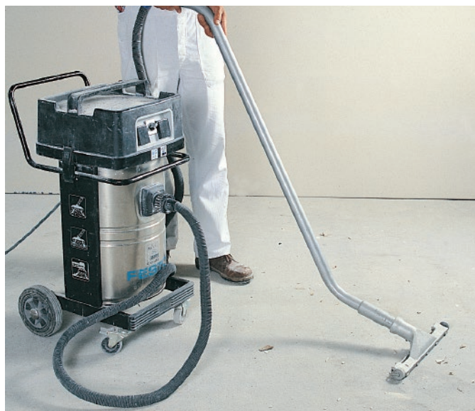
Grafika 20: Czyszczenie za pomocą odkurzacza przemysłowego
