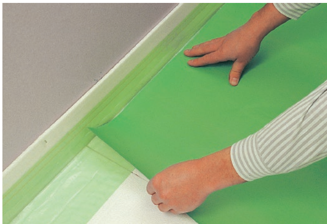
Grafika 8: Układanie warstwy papieru parafinowego Knauf
