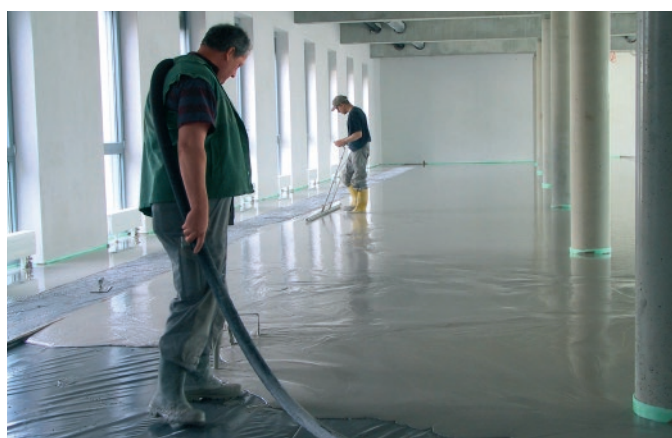
Grafika 15: Układanie płynnego podkładu na przygotowanej konstrukcji podłogi podniesionej
