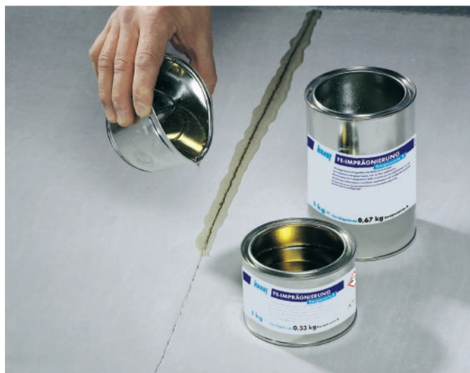
Grafika 54: Wypełnianie pęknięć żywicą epoksydową
