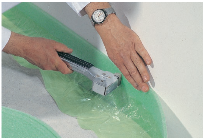
Grafika 22: Przymocować brzegową taśmę dylatacyjną Knauf z fartuchem foliowym (również przy rurach, wspornikach, itp.), nie mocować zszywkami na wysokości podkładu
