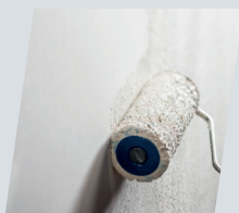
Skimming - Volvlakkig plamuren (F2b/F3)
