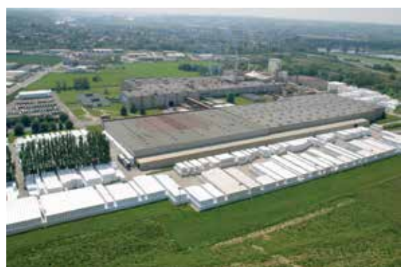
Productiesite Knauf Insulation Visé
