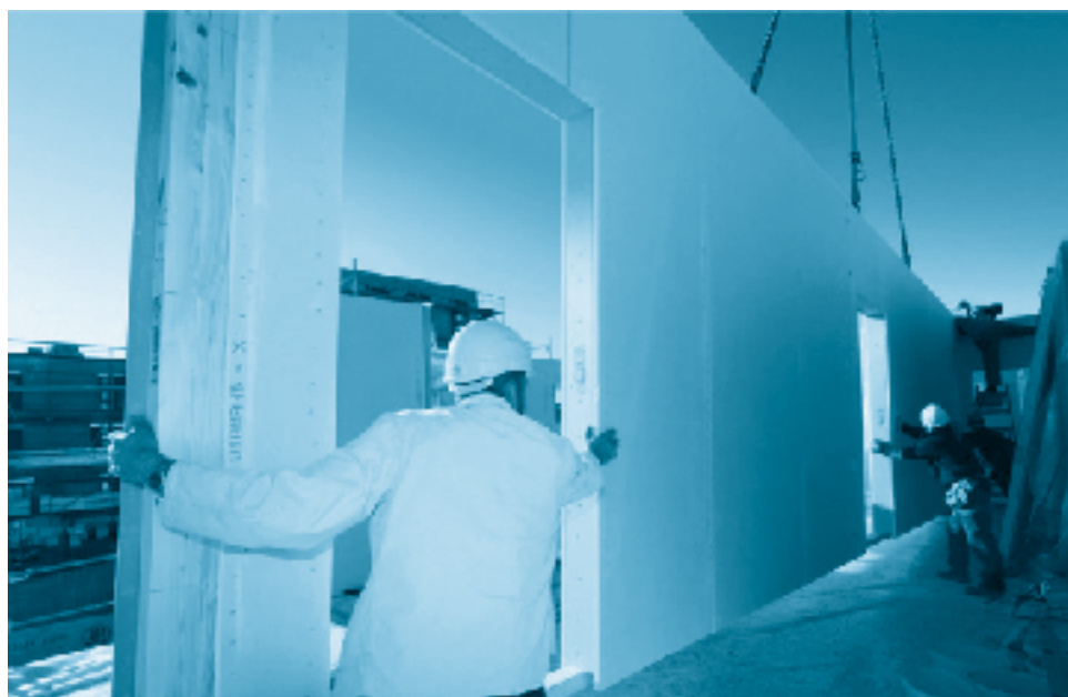
Фигура 3 Монтажна стенна конструкция
