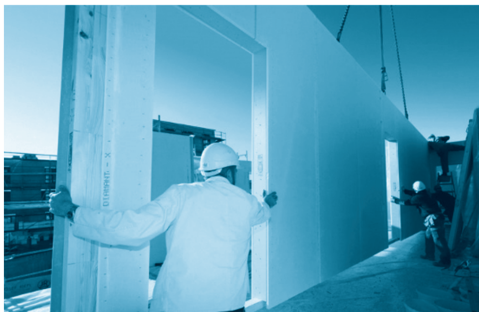
Фигура 3 Монтажна стенна конструкция
