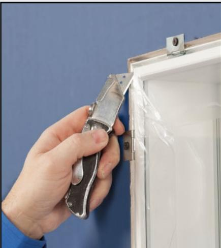
Unmittelbar vor Aufsetzen der Abdeckrahmen die Folie mit einem Messer einschneiden.
