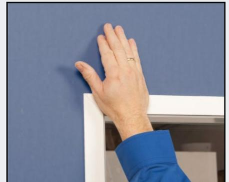
Abdeckrahmen, auf die oberflächenfertige Wand aufsetzen. Abdeckrahmensteg so in die Clipfeder positionieren, dass die Glasdichtung vom Abdeckrahmen an die Scheibe gedrückt wird (siehe Detail). An allen vier Ecken beginnen und zur Mitte hin in die Clips einrasten lassen.
