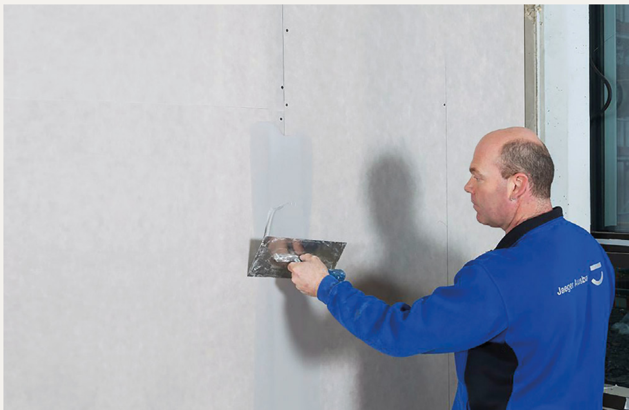
Afvoegen van Drystar Board met Drystar-Filler 60, in dit geval met Kurt wapeningsband.
