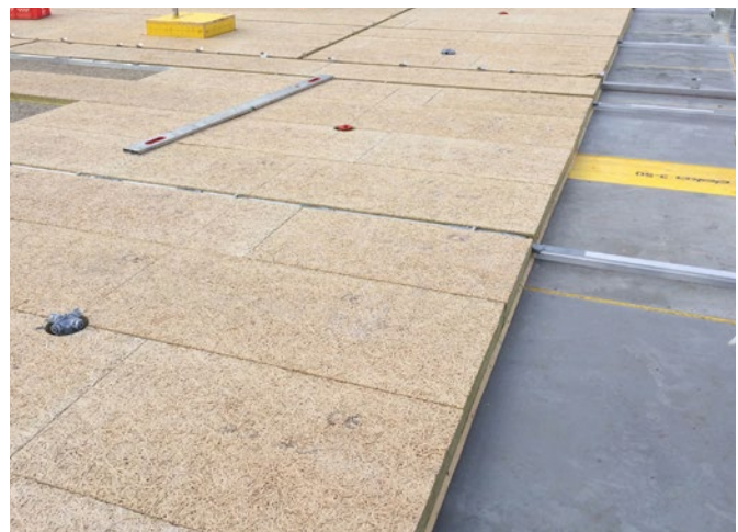
Einlegen der Tektalan A2-SD in die Schalung ▶
