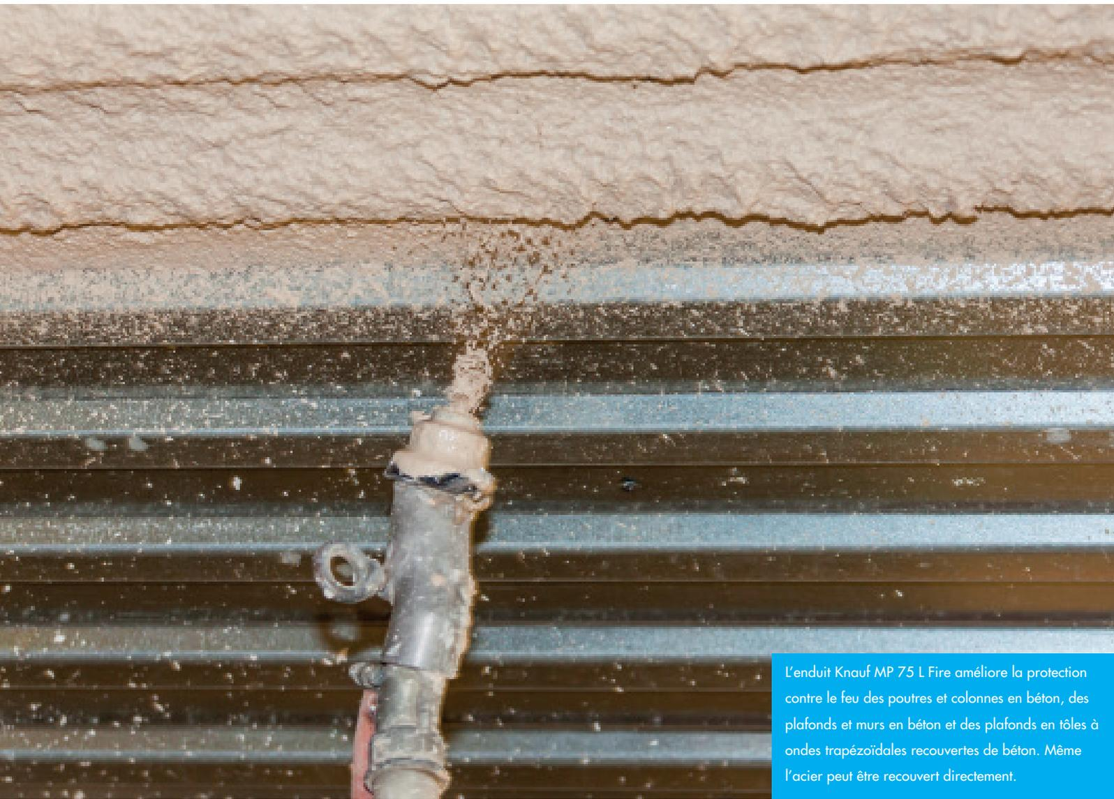
L'enduit Knauf MP 75 L Fire améliore la protection contre le feu des poutres et colonnes en béton, des plafonds et murs en béton et des plafonds en tôles à ondes trapézoïdales recouvertes de béton. Même l'acier peut être recouvert directement.
