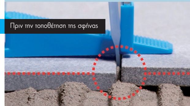
Πριν την τοποθέτηση της σφήνας
