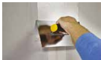
Az illesztést 30 cm szélességben simítsuk le.
