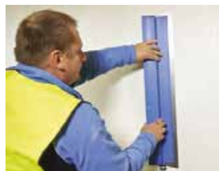
Falfelületen Q2 minőségű felületre széles simítóval elhúzott 2-3 mm vastag glettelés, vékonyvakolat.
