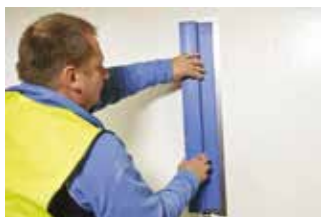
Simítsuk szélesen le a felületet és finoman csiszoljuk meg az esetleges érdességet.
