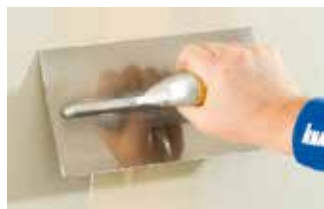
Gyári élképzésnél simítóval szélesen simítjuk (húzzuk) le az illesztést.
