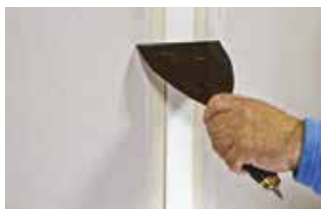
A vágott éleket csiszolóval vagy élglyaluvallaljuk le. Vágott éleknél hézagerősítő szalag szükséges, amit az első hézagkitöltésbe ágyazzunk és egyszer simítsuk le.
