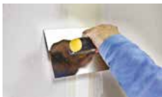
Vágott élnél is 30 cm szélesen szükséges a lesimítás.
