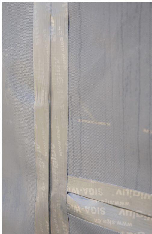
5. Sellado unión entre membranas Homeseal LDS 0,02 UV
