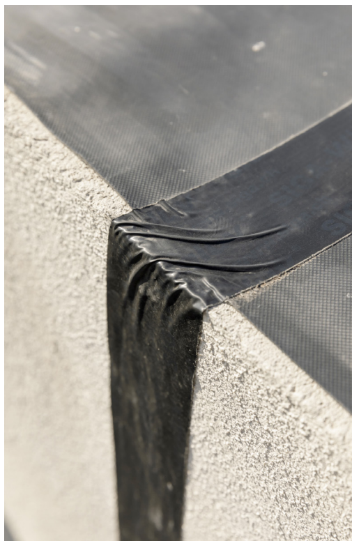
3. Sellado peto de cubierta
