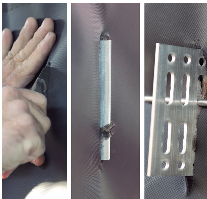
Figura 10. Corte vertical coincidiendo con ménsula
