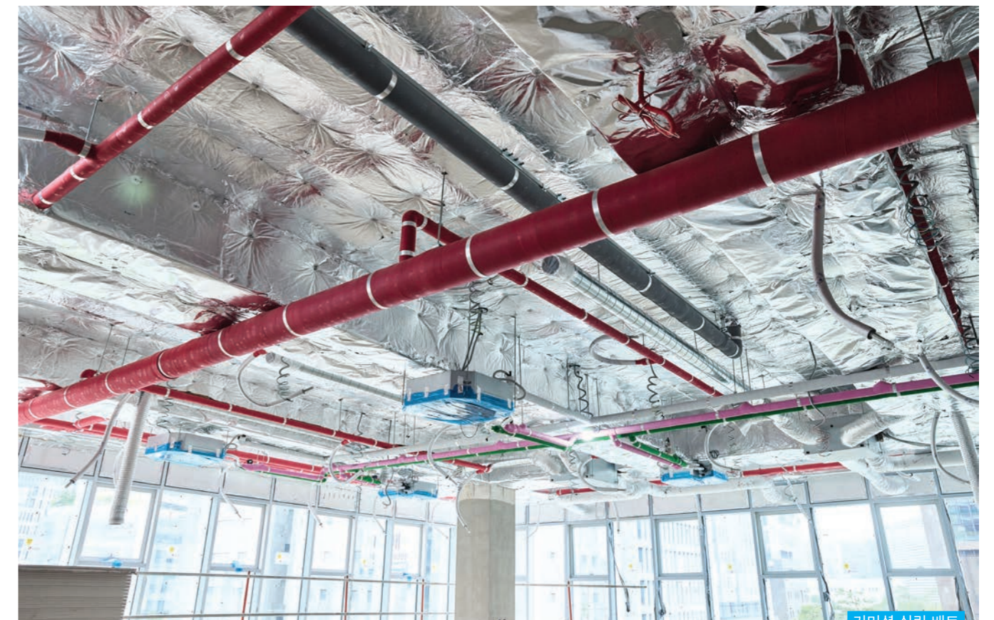
커머셜 실링 배트 시공된 단열재의 화스너 고정 수량은 권장 기준과 상이할 수 있습니다.
