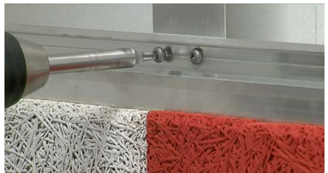
Befestigen des Tragprofils mittels zwei Bohrschrauben 4,8 x 20 mm pro Grundprofil. Setzen Sie die erste Bohrschraube nahe an das Eck des Grundprofils.
