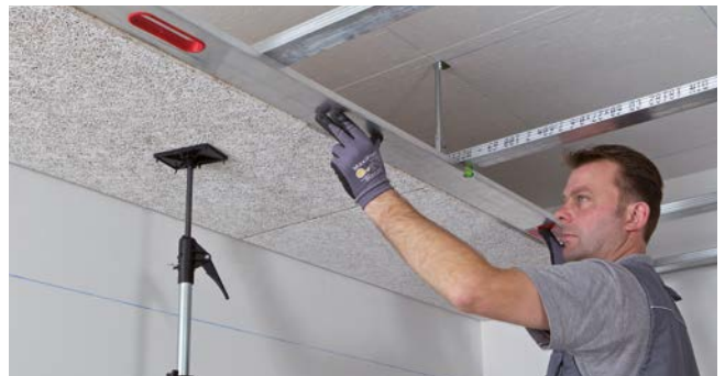
Ausfluchten der Plattenreihen mit Verlegetlatte. Plattenstöße müssen mittig unter dem Profil angeordnet sein. Keine freien, schwebenden Plattenstöße zulässig! Die auf der Plattenrückseite gekennzeichnete Verlegerichtung ist bei der Verle- gung von quadratischen Platten zu beachten.
