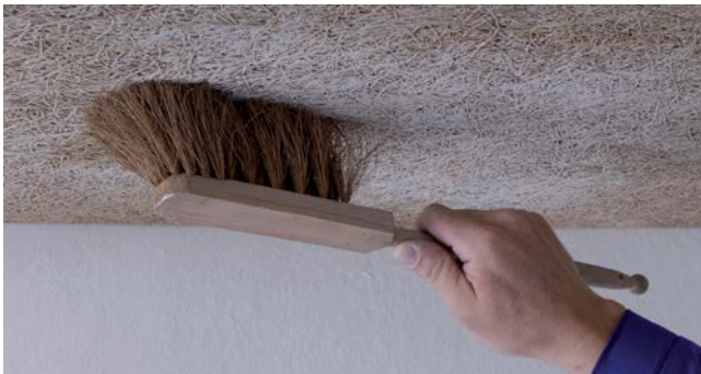
Abbürsten: Ausblühungen, Staub etc. können mit einer weichen Bürste entfernt werden. Gelockerte Fasern mit Primer StoPrim Plex verfestigen.
