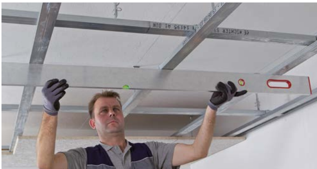
Ausfluchten der CD-Profile mittels Wasserwaage oder Lasergerät.
