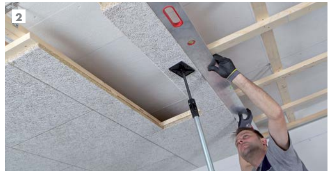
2 Montage der Passstreifen
