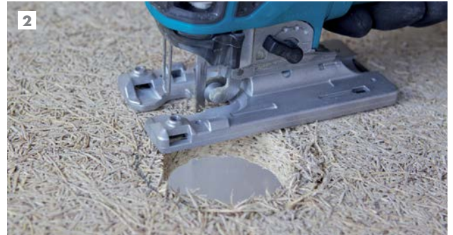
2 Ausschneiden einer Öffnung mittels Stichsäge. Die Sichtseite der Platte ist unten.
