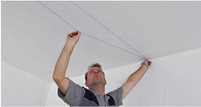
Auftragen des Deckenrasters von der Raummitte aus, z.B. mittels Schnur- schlag. Achten auf gleich große Randfelder.
