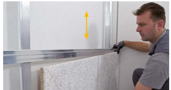
Tragprofil zuerst am Ende nur mit einer Schraube fixieren, so dass das andere Ende in der Höhe beweglich bleibt. Dies vereinfacht das Einschieben der weiteren Platten.
