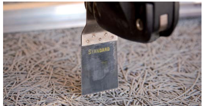
Ausschneiden von Öffnungen durch „Supercutter“ Schnittrichtung nur rechtwinklig zur Plattenoberfläche ausführen.
