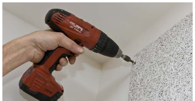
Befestigen der letzten Platte mittels Schraube, wenn ein seitliches Verschieben der Platte nicht möglich ist. Uneingefärbte Schraubenköpfe mit Plattenfarbe und feinem Pinsel abdecken.
