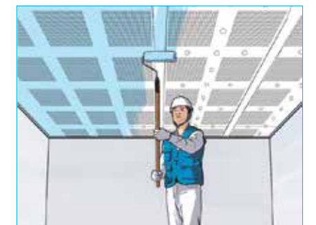
6 이음매 부위 컴파운드 도포 건조 후 페인트 도포를 하여 시공을 마무리합니다.
