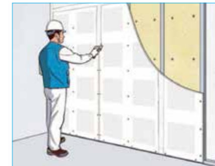
5 이음매 부위 조인트 컴파운드 시공
