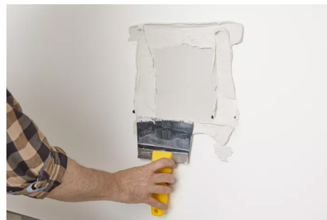
6. Naden vullen met Knauf Uniflott
