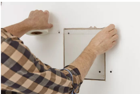
5. Zelfklevend gaasband op de naden aanbrenge
