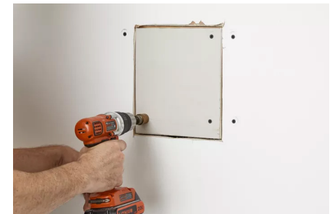
4. Stuk gipsplaat bevestigen
