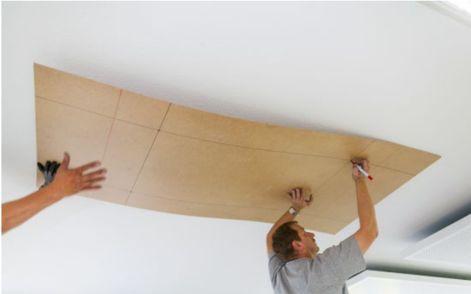
Bild 4: Übertragung der Abhängepunkte
