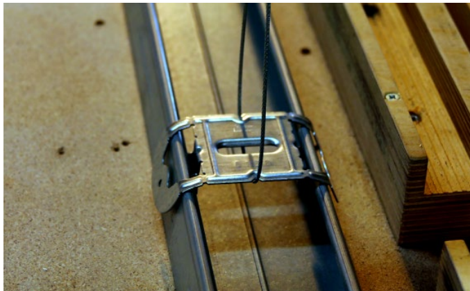
Bild 10: Durchführen des Drahtseils unter dem Direktmontage-Clip
