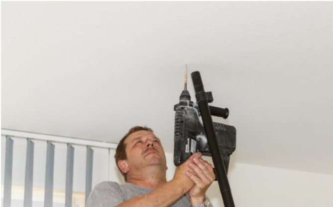
Bild 5: Bohren der Löcher für die Abhängung
