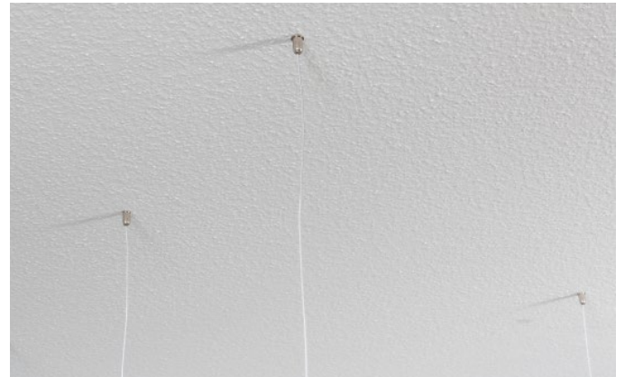
Bild 8: Abhänger an der Decke
