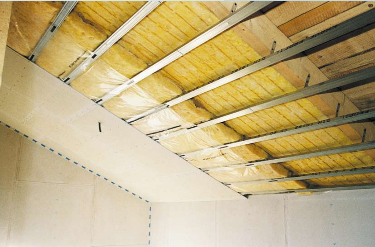
Correcte montage van de Vidiwall VT gipsvezelplaten als bekleding van een zolderkamer.
