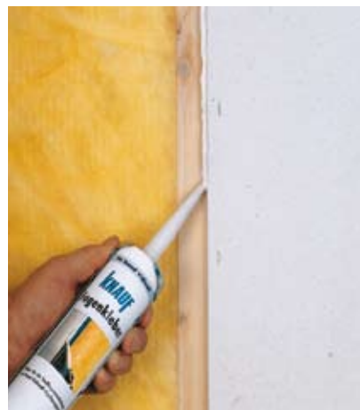
Op de SK-kant de speciale Vidiwall voeglijm aanbrengen.
