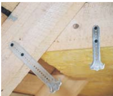
Bevestiging aan de onderconstructie: Knauf ankerafhanger 90 mm of 200 mm.
