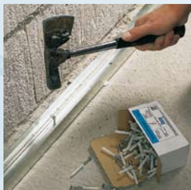
Bevestigen van het Knauf profiel UD 28/27
