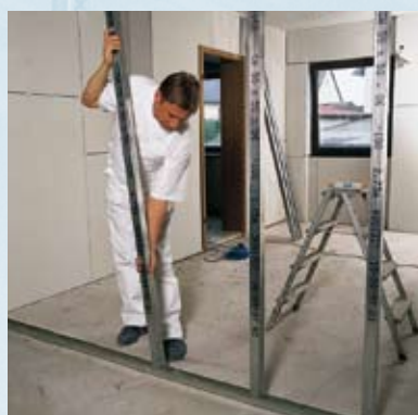
Plaatsen van de Knauf profielen CW in de Knauf profielen UW
