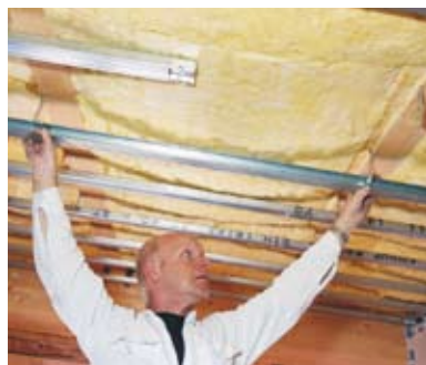
Inhaken van de Knauf profielen CD 60/27 aan de ankerafhangers.
