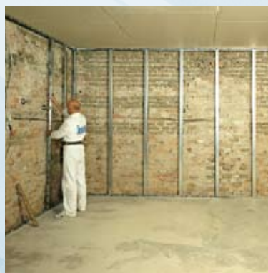
Montage van de Knauf profielen CD 60/27
