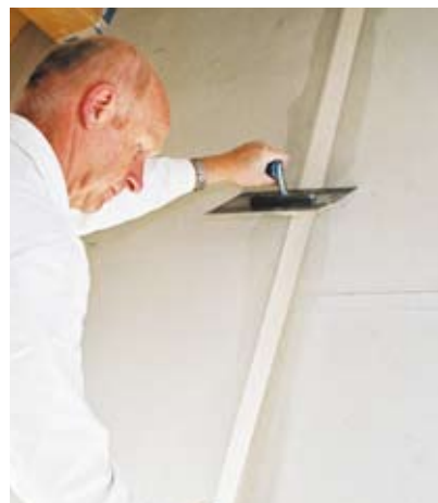
De voegband aanbrengen.
