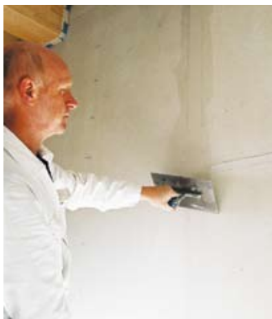
De VT-voeg opvullen met het voegmateriaal.
