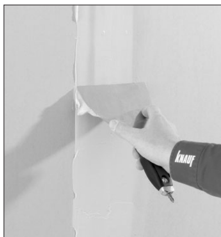
1. Pracovný krok - Safeboard-Spachtel
