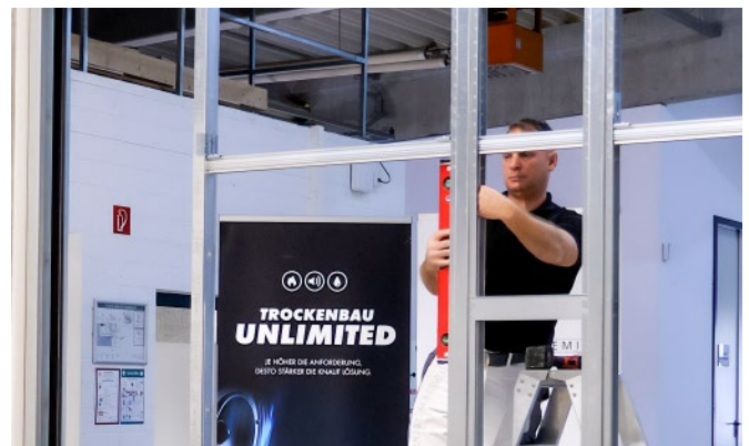
Bild 42: Taschenprofile ausrichten
