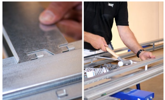
Bild 19: Distanzset montieren
