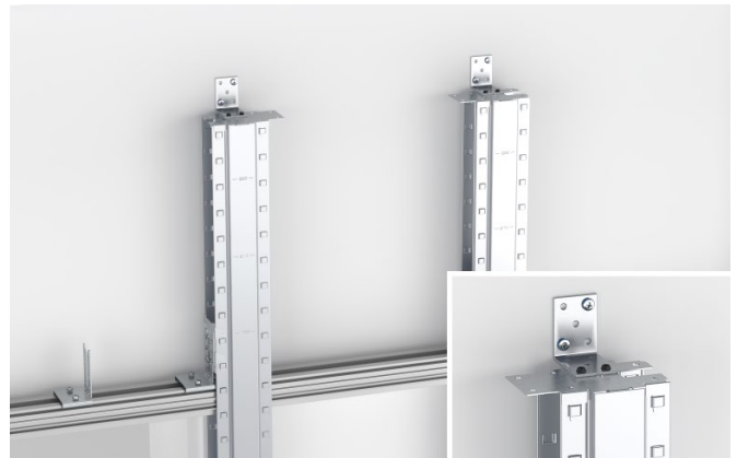
Bild 60: Montage in der Vorsatzschale
