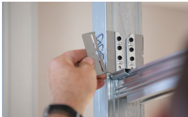
Bild 56: CW-Profil mit UW-Deckenprofil verbinden
