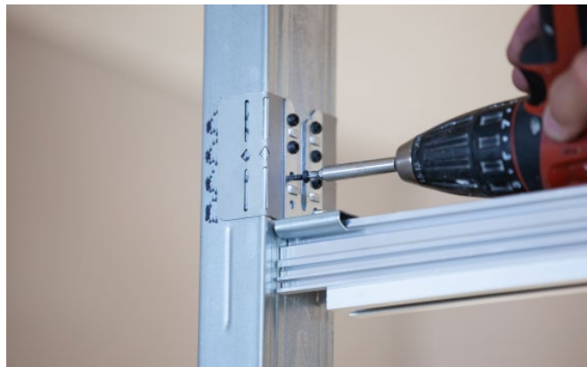
Bild 55: Sicherungslaschen entfernen
