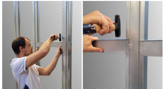
Bild 81: Befestigung Tragschiene
