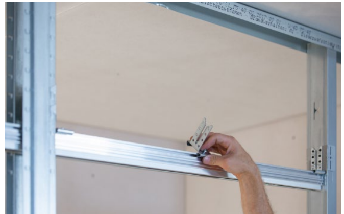
Bild 58: Unterkonstruktion Wand einsetzen
