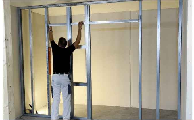
Bild 40: Sicherungslaschen umklappen
