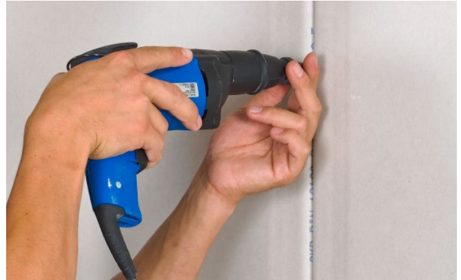
Bild 67: Entfernen der Abstandshalter
