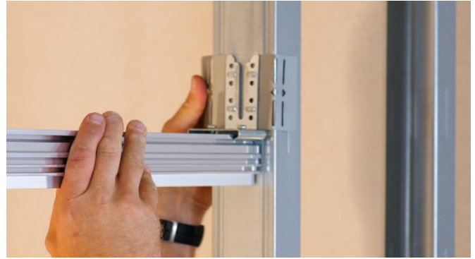
Bild 80: Taschenprofile über die Traversen verbinden
