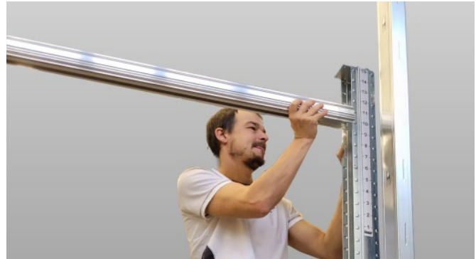
Bild 77: Positionieren des Taschenprofils
