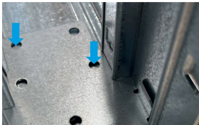
Bild 57: Befestigung der Verbindungsplatten
