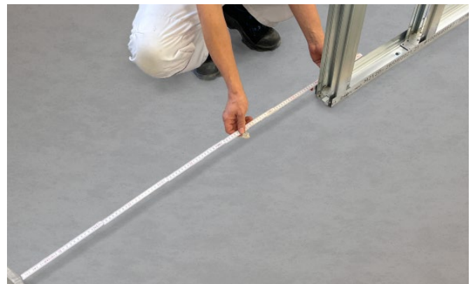
Bild 42: Taschenprofile ausrichten
