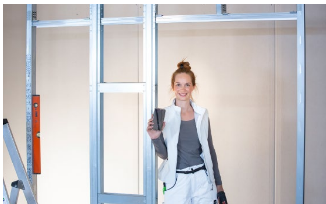
Bild 65: Vorbereitung für Beplankung
