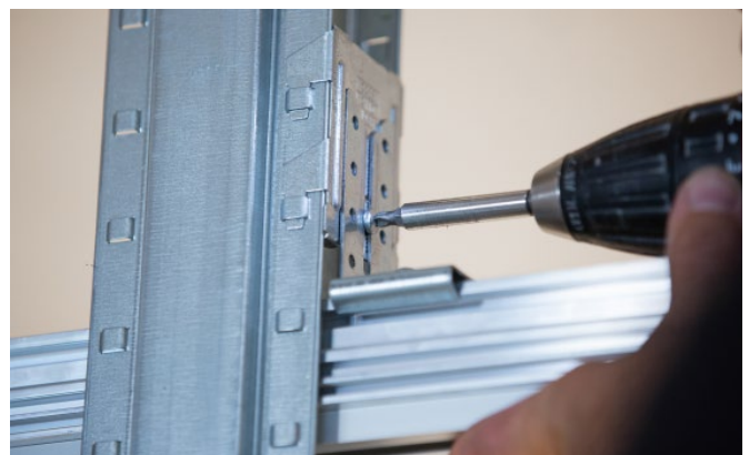
Bild 53: Distanzsets fixieren
