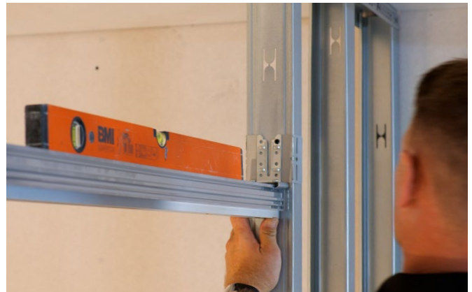
Bild 53: Distanzsets fixieren
