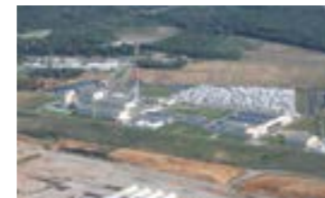
Lannemezan pour la laine minérale de verre et la laine minérale de verre à souffler. Production annuelle : 93 000 T
