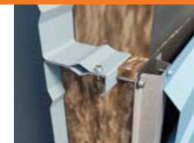
CAS 2 : CAS D'UN BARDAGE HORIZONTAL
