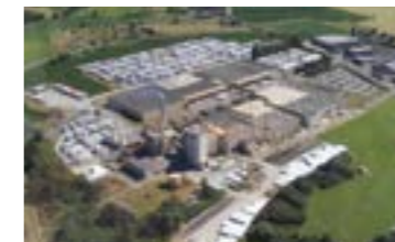
Illange pour la laine minérale de roche. Production annuelle : 100 000 T
