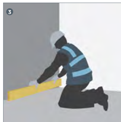
3 Montér Knauf kantstrimler ved vægtilslutninger.
