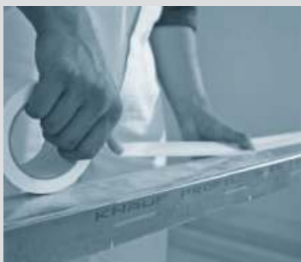
1. Samoljepljiva Trenn-Fix traka se pritisne za CW/UW ili UD profil
