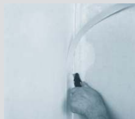
6. Nakon sušenja treba odrezati višak razdjelne trake
