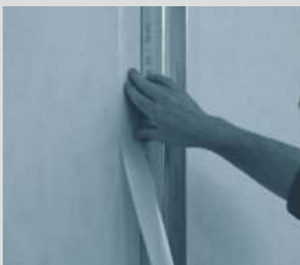
2. Alternativno se Trenn-Fix može lijepiti na građevinski dio na mjestu spoja
