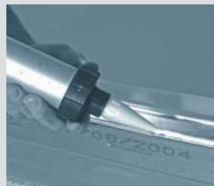
3. Na profil se nanosi Knauf brtveni kit kao akustična brtva spoja
