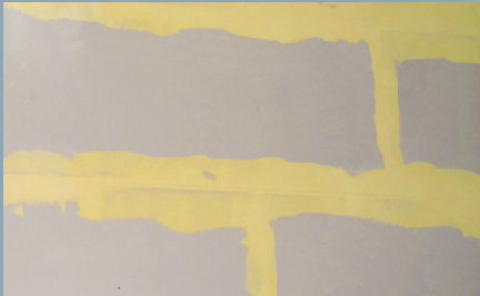
Szpachlowanie żółtą masą Safeboard-Spachtel dla zapewnienia maksymalnego bezpieczeństwa
