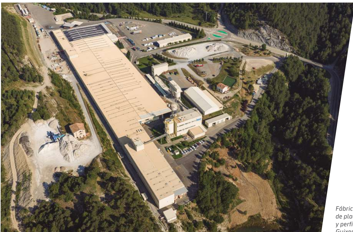
Fábrica Knauf de placa de yeso, perfilera, pastas y enlucidos en Escúzar, Granada.
