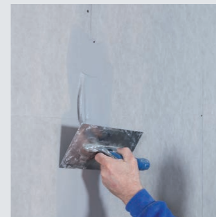
Korak 1: Ispuniti spojeve Drystar Filler
