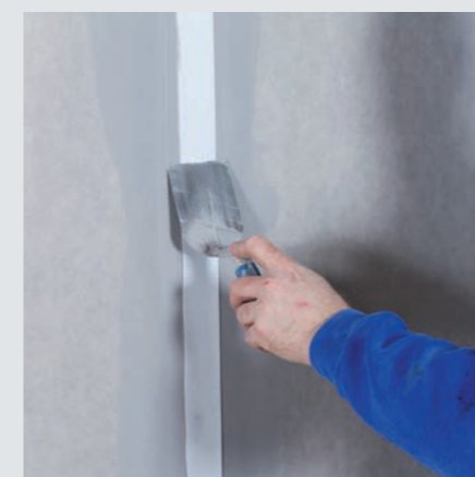
Korak 3: Utisnuti Knauf bandažnu traku od staklenih vlakana
