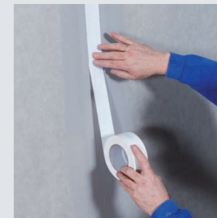
Korak 2: Postaviti Knauf bandažnu traku od staklenih vlakana
