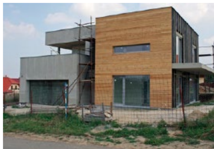
Větraná fasáda rodinného domu
