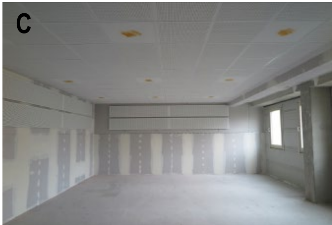
C Raum mit Akustikdecke ohne Möblierung, mit Wandabsorbern
