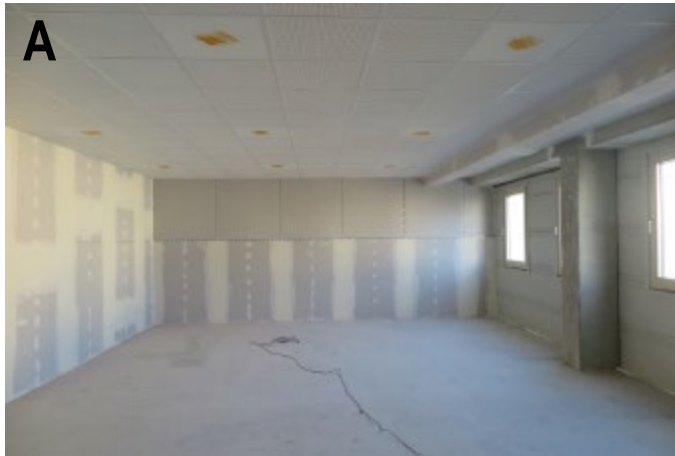
A Raum mit Akustikdecke ohne Möblierung, ohne Wandabsorber
