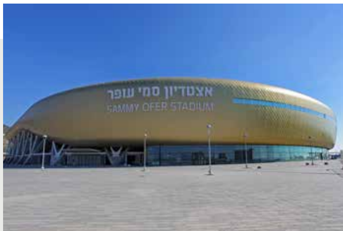
אצטדיון סמי עופר, חיפה ישראל. מנספלד קהת - אדריכלים.
