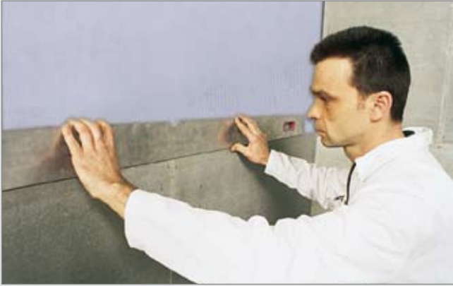
1. Ensimmäinen AQUAPANEL® Indoor -levy kiinnitetään rankoihin vaakasuoraan. 2400mm -pituiset levyt asennetaan pystysuoraan kipsilevyjen tavoin.
