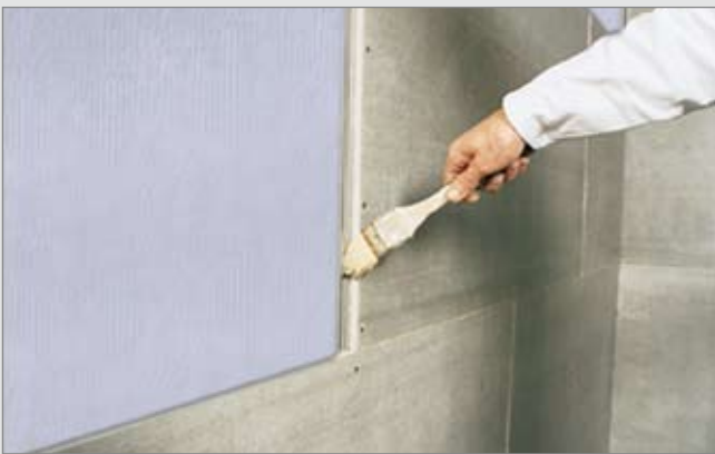
3. Hyvän liimatartunnan (AQUAPANEL® Joint Adhesive) varmistamiseksi levyreunat puhdistetaan määrällä siveltimellä ennen liiman levitystä.
