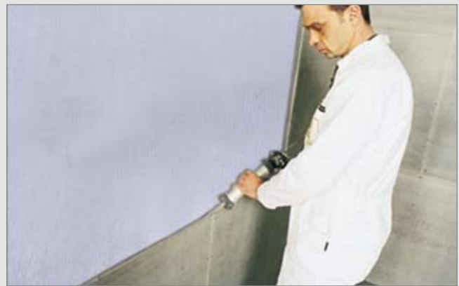
4. Levyreunoille pursotetaan AQUAPANEL® Joint Adhesive -saumaliimaa.
