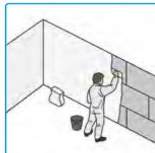
A continuación se presenta la Malla Superficial AQUAPANEL® sobre el Mortero Superficial (sin apretar demasiado), y se le aplica una fina capa de Mortero Superficial para cubrir la malla. De esta forma, la malla queda embebida en el tercio exterior del mortero base. Con esto se consigue un acabado Q2.
