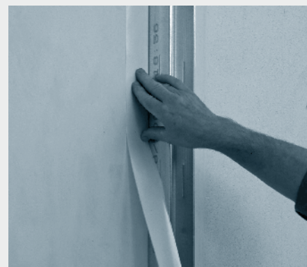
3. Alternativno ločilni trak nalepimo na gradbeni element, ki se stika.
