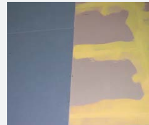
Bovenste plaatlaag van Knauf Diamond Board (blauw) geeft een perfecte en harde afwerking
