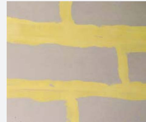
De gele kleur van de Safeboard-Spachtel maakt de controle op de toepassing van het juiste materiaal gemakkelijk
