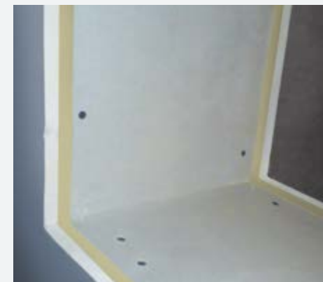
Gemakkelijke visuele controle door de gele kleur van Knauf Safeboard
