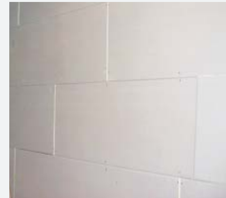
Gemonteerde Knauf Safeboard platen
