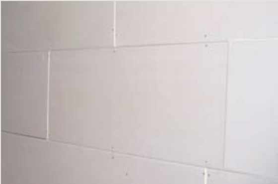
Gemonteerde Safeboard platen
