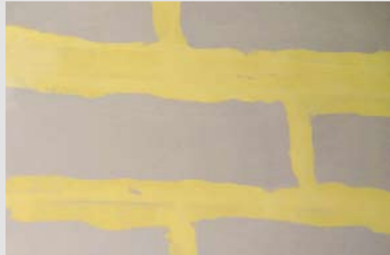
De gele kleur van de Safeboard-Spachtel maakt de controle op de toepassing van het juiste materiaal gemakkelijk
