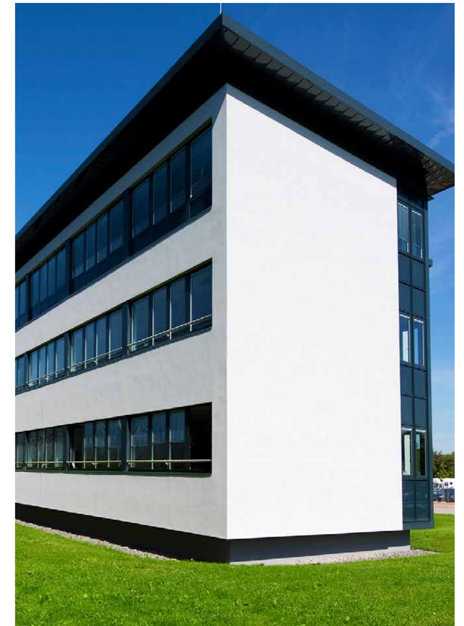
Kantoorgebouw | Voerde, Duitsland
