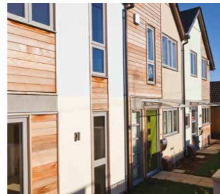
Woningbouw | Ringwood, Verenigd Koninkrijk
