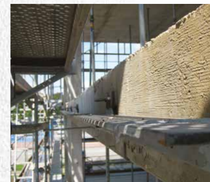
Kantoorgebouw | Voerde, Duitsland
