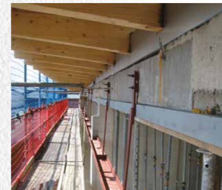
Kantoorgebouw | Voerde, Duitsland
