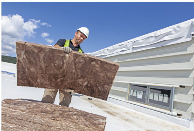
Izolant je dodáván v deskách ve shodných rozměrech jako kazety.
