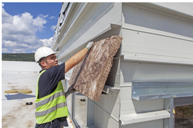
Izolant se instaluje vložením do kazet a ve fázi montáže se fixuje pouhým třením
