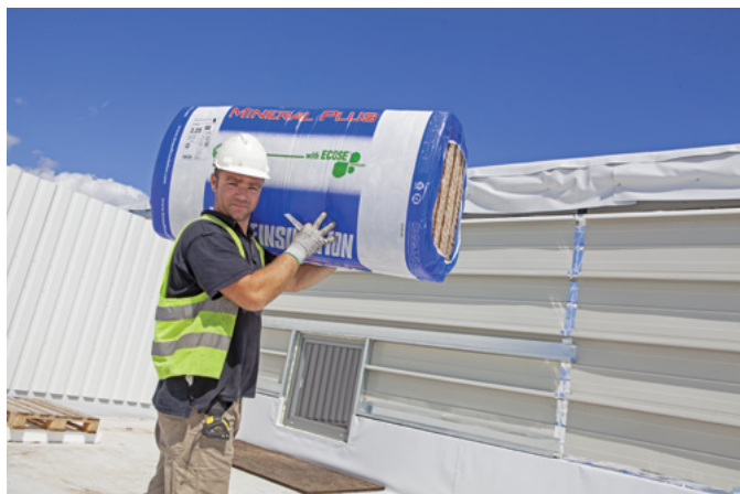
Spodní vrstvu skladby tvoří izolace Mineral Plus.
