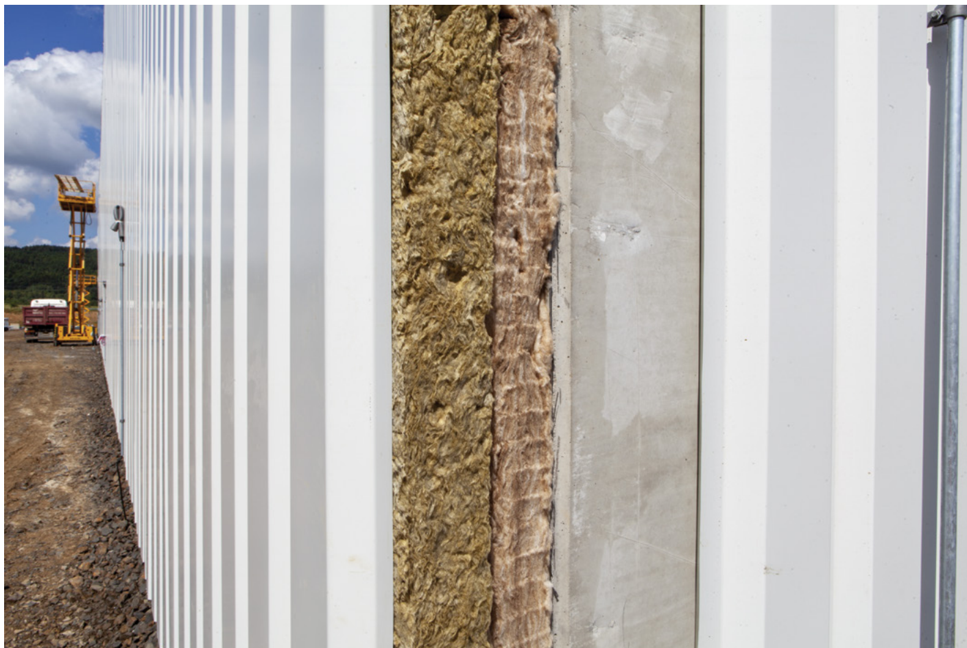
Jednotlivé vrstvy systému Duotherm v řezu.
