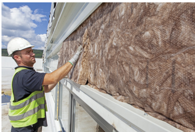
Díky pružnosti izolace dochází k vyplnění všech dutin a škvír v konstrukci.
