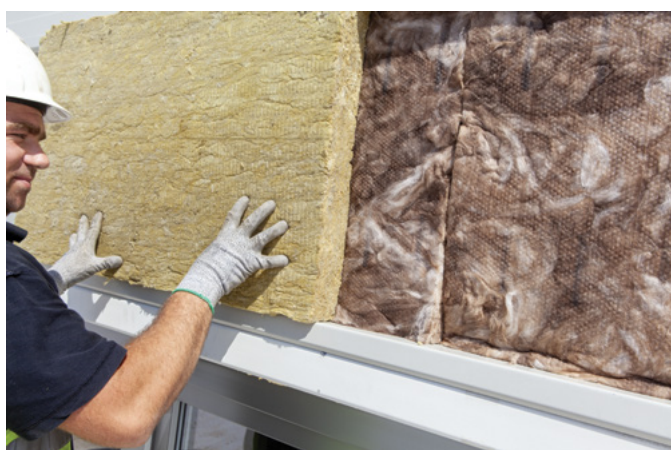
Druhou, tepelně izolační vrstvou je deska FRE-P tvořená čedičovou vatou. Díky fabrickému nařiznutí drží pevně za nos kazety.
