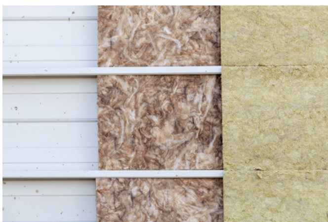
Pohled na jednotlivé vrstvy Duo therm připravené k zarkytí finálním obkladem.
