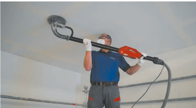
17 Die verspachtelten Plattenstöße und Befestigungspunkte mit Schleifpapier (Körnung 150) abschleifen, sodass sie glatt und eben sind.
