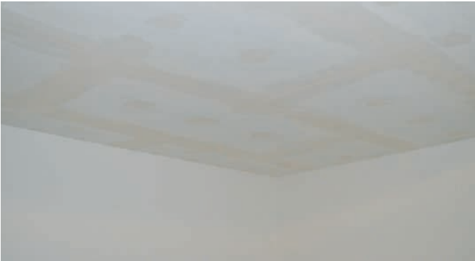
15 ELEGANZA Acoustic Joint Finish mindestens 8 Stunden oder so lange wie aufgrund der Umgebungsbedingungen erforderlich trocknen lassen (siehe Seite 4).
