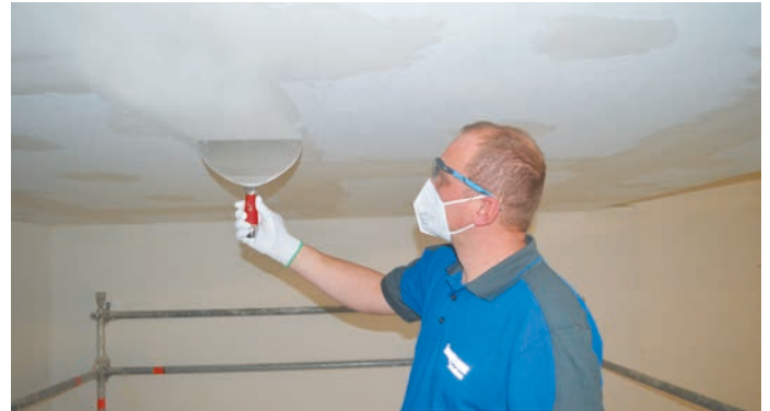
16 Nach dem Trocknen die Ebenheit des ELEGANZA Acoustic Joint Finish kontrollieren und ggf. Unebenheiten mit der Trockenbau-Fugenspachtel ausbessern.
