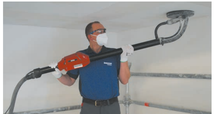
18 Die Vorderseite der ELEGANZA Platte mit Schleifpapier (Körnung 150) leicht abschleifen.
