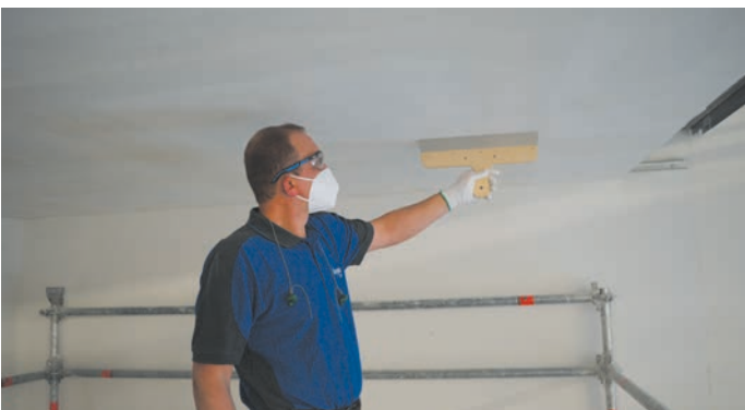
19 Nach dem Abschleifen die Ebenheit der Plattenstöße und Befestigungspunkte kontrollieren.
