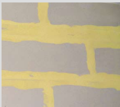
Фугиране с жълт шпакловъчен материал Safeboard за най-висока сигурност
