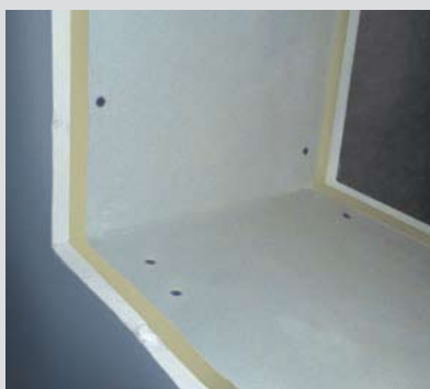
Лесен технически контрол чрез жълтото ядро на плоскостта
