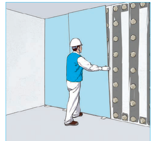
4 고강도 일반석고보드(Hardwall) 시공
