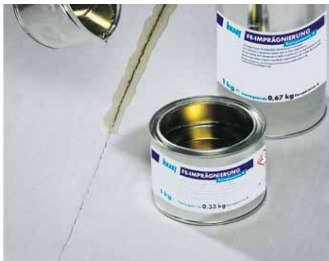
Joonis 71: Pragude täitmine epoksüvaiguga
