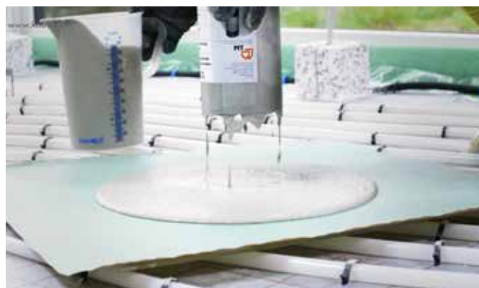
Joonis 47: Tõmmake konsistentsi katsetoos üles
