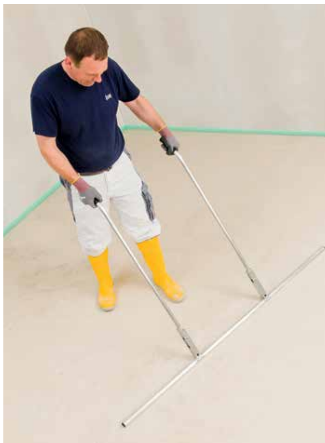
Joonis 81: Põrandasegu raputamine spetsiaalse torulatiga
