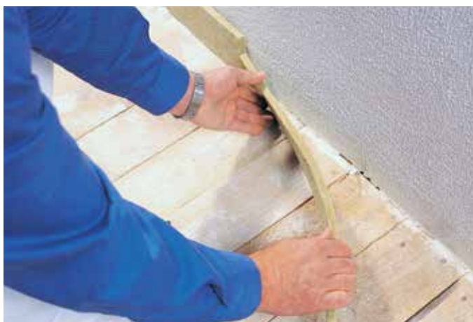
Joonis 32: Mineraalvillast servaisolatsiooniribade paigaldamine tuleohutusnõuete täitmiseks
