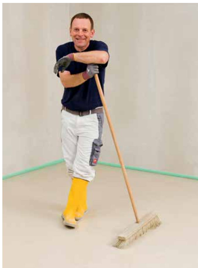
Joonis 83: Siledamad pinnad tänu põrandaharjaga töötlemisele
