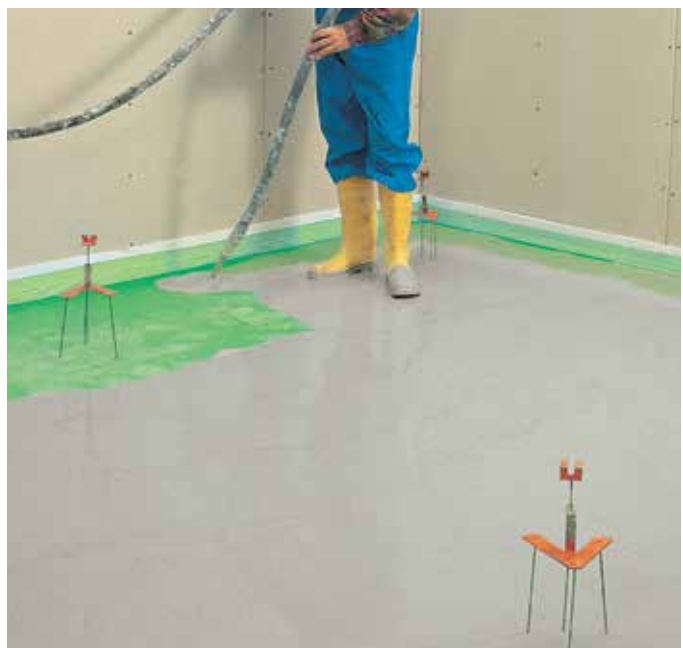
Joonis 50: FE-kipsivalu valamine
