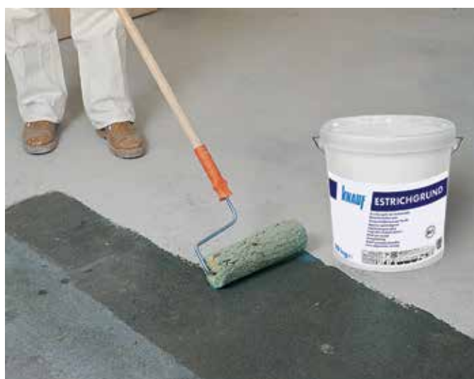
Joonis 72: Krundi Estrichgrund pealekandmine
