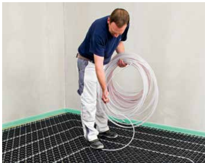
Joonis 79: Kütetorustiku paigaldamine
