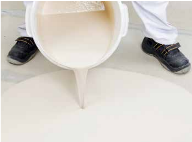
Joonis 73: Käsitsi paigaldamine N 410
