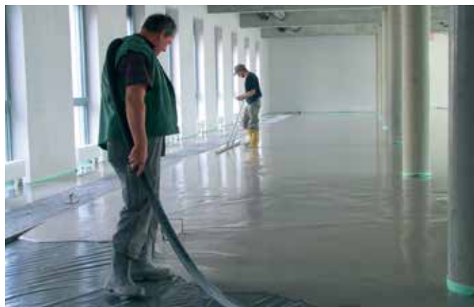
Joonis 24: Mõrdi valamine õõnespõranda alusplaadile
