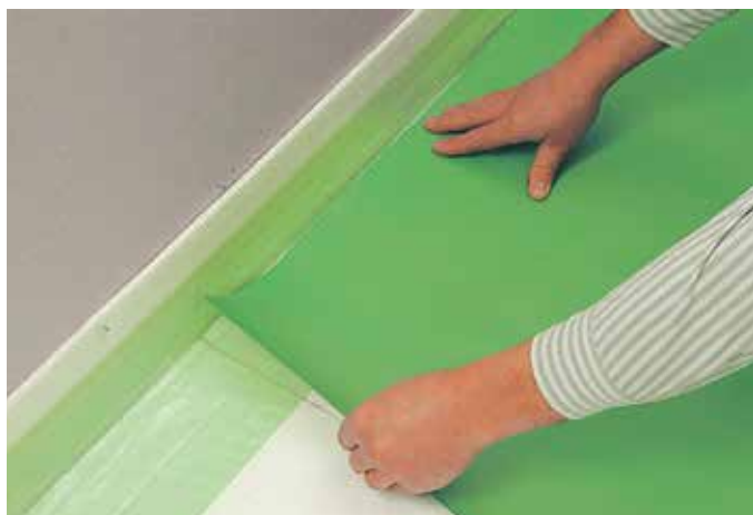
Joonis 17: Knaufi aluspaberi paigaldamine
