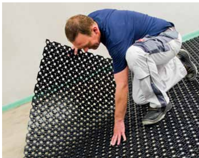
Joonis 78: Liimige kütetorude mullplaat ettevalmistatud aluspinnale.
