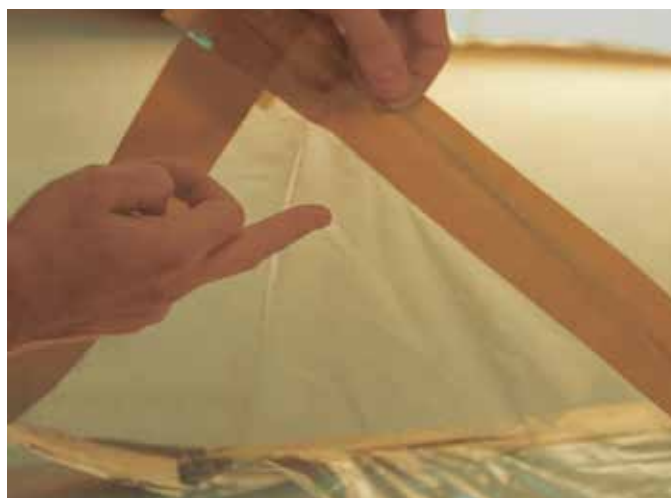
Joonis 60: Kontrollige, kas kile all on kondensaati
