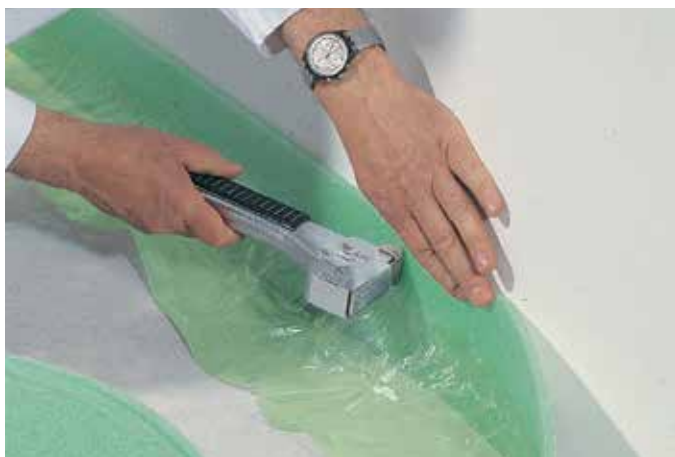
Joonis 31: Kinnitage servaisolatsiooniribad (ka torude, küttepüstikute jne külge); ärge kinnitage klambritega tasanduskihi kõrguses
