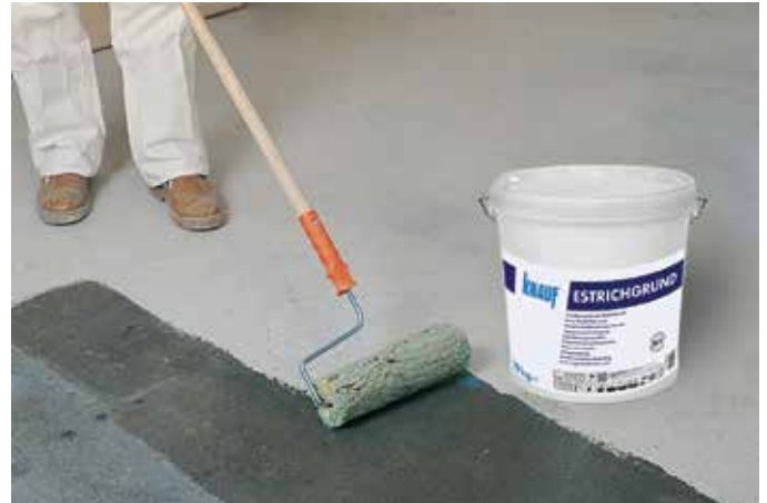
Joonis 13: Kandke krunt Estrichgrund pinnale
