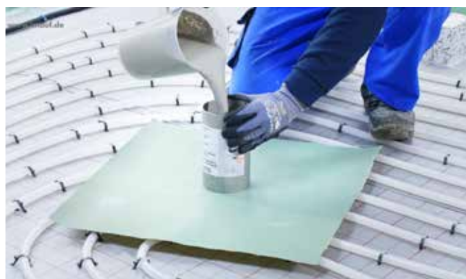
Joonis 46: Täitke konsistentsi katsetoos mördiga
