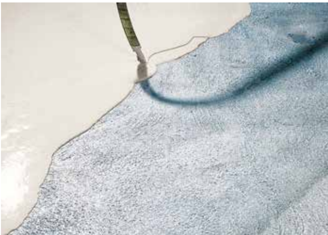
Joonis 74: Masinaga N 410 valamine
