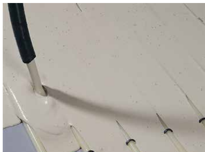
Joonis 19: Põrandaküttega valukihi paigaldamine
