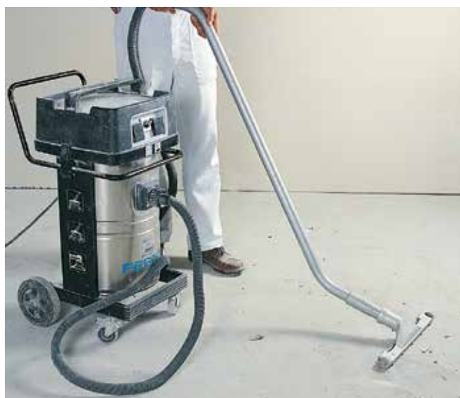
Joonis 29: Puhastamine tööstusliku tolmuimejaga
