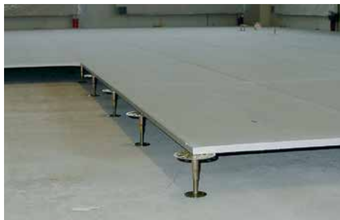
Joonis 23: Postide ja plaatkatte paigaldamine
