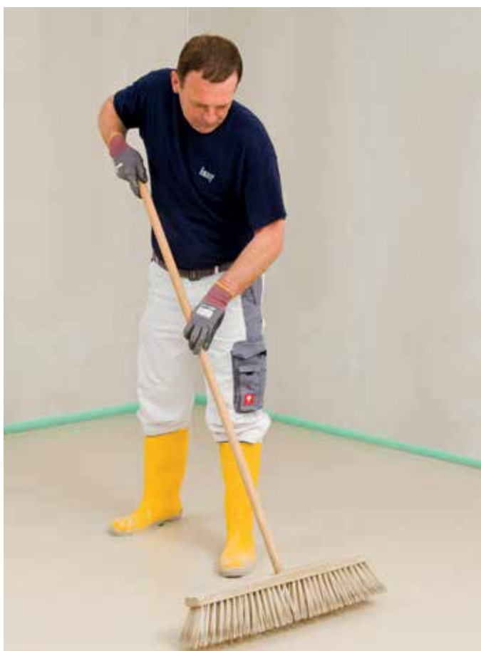
Joonis 82: Põrandaharjaga ühtlaseks raputamine
